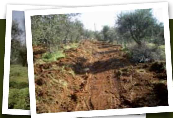
Projektstart - Anlegen der negativ geneigten Terrassen
